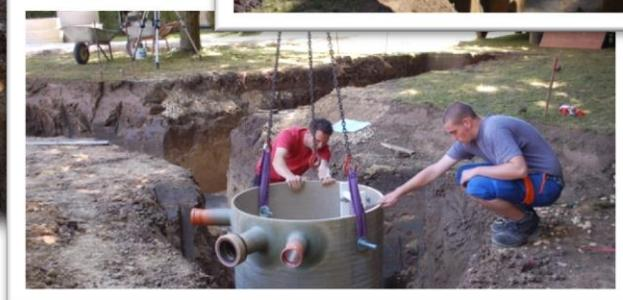
Das Setzen des Steinzeugschachtes dagegen stellte sich als Herausforderung besonderer Art dar, weil die zur Verfügung stehenden Baumaschinen für diese Aufgabe unterdimensioniert waren.
