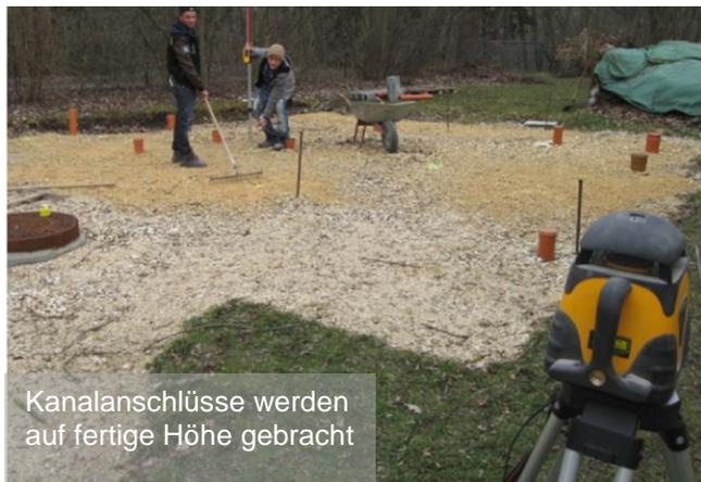
Kanalanschlüsse werden auf fertige Höhe gebracht
