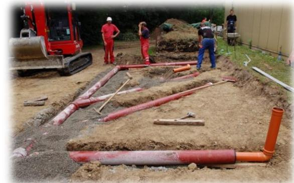
Der Schacht S2 besitzt einen innenliegenden Absturz, daran angeschlossen ist die Grundstücksentwässerungsanlage GEA 2 nach DIN 1986 (neu), ein Trennsystem in der Grundstücksentwässerung mit Steinzeugrohren.
