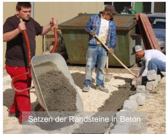
Setzen der Randsteine in Beton
