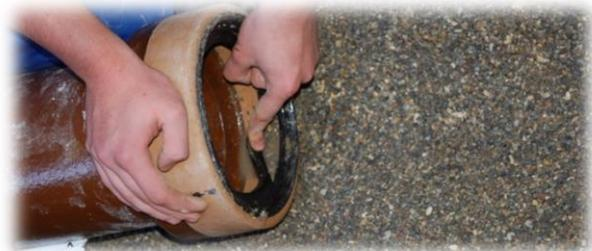
Die Dichtheitsprüfung mit Luft und Wasser war wegen einer defekten Dichtung nicht erfolgreich. Das Rohr musste ausgetauscht werden.
